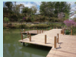
修大池デッキ等の改修 (2018年度)
