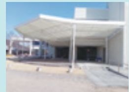
修大フォーラム棟 屋外ウッドデッキの修繕(2020年度) 屋外ステージ屋根テントの張替(2021年度)
