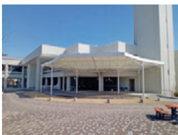
修大フォーラム棟屋外ステージ 屋根TENT張替改修
