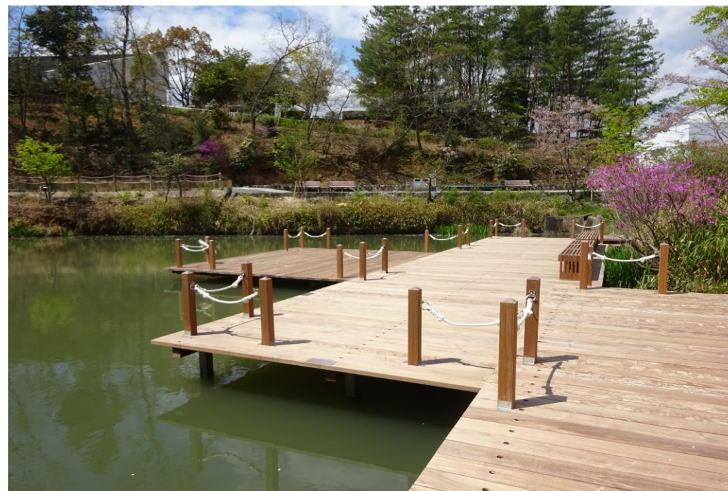
修大池デッキ等の改修 (2018年度)
