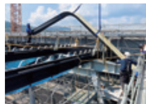
2024年9月 屋根施工
