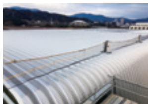
2025年1月 屋根完成
