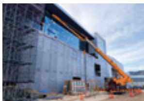
2024年12月 北面ガラス取付
