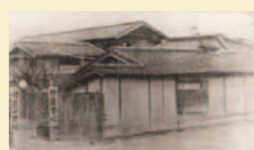
▲修道中学校・修道学校 校舎(八丁堀) (1887~1960年)
