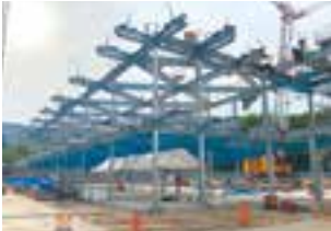
鉄骨建方工事の様子
