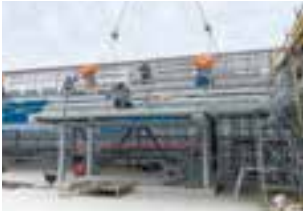
プレキャストコンクリート段床（3階 観客席ベンチ部分）設置の様子
