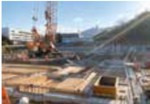
1階床面型枠組立工事の様子
