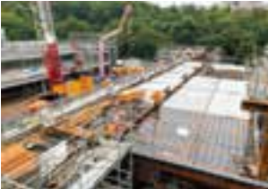
3階床面施工の様子
