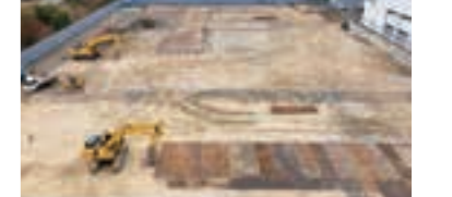
▲基礎掘削工事
