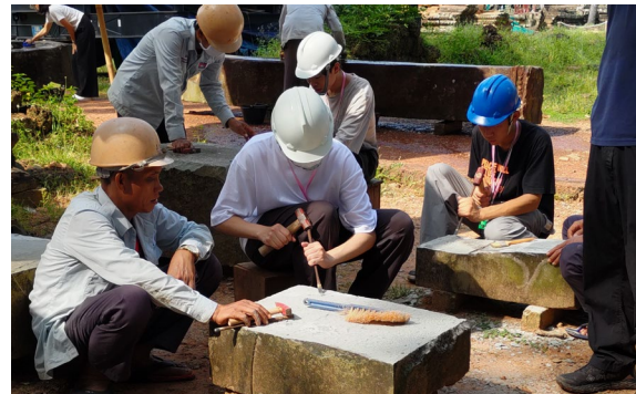
アンコール・トム遺跡で、なんと遺跡修復作業にかかわることができました。削ったり、磨いたり。この岩が未来への遺産になるのです。
